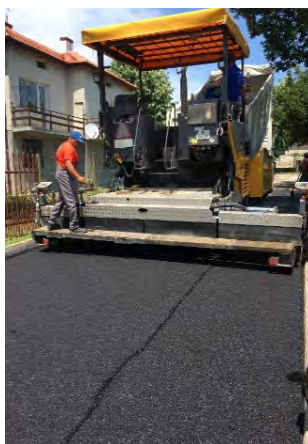
Полагане на смес от RAP, Фрезобит и уплътняване
