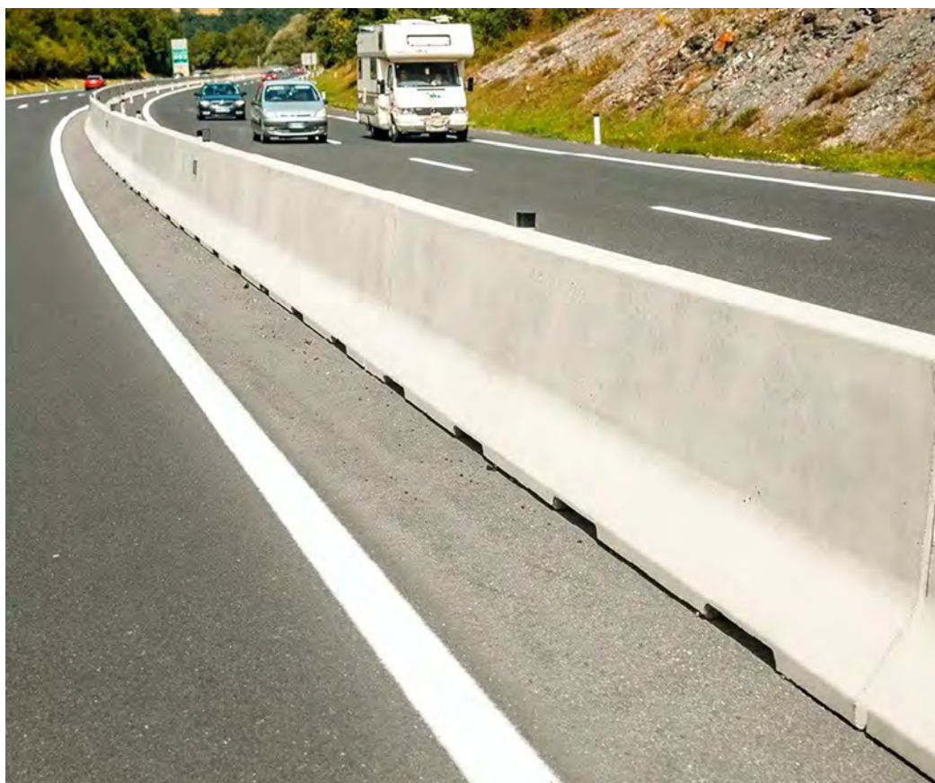
Фиг. № 5 „Бетонова ограда с профил „Ню Джърси“ по разделителна ивица на автомагистрала“
