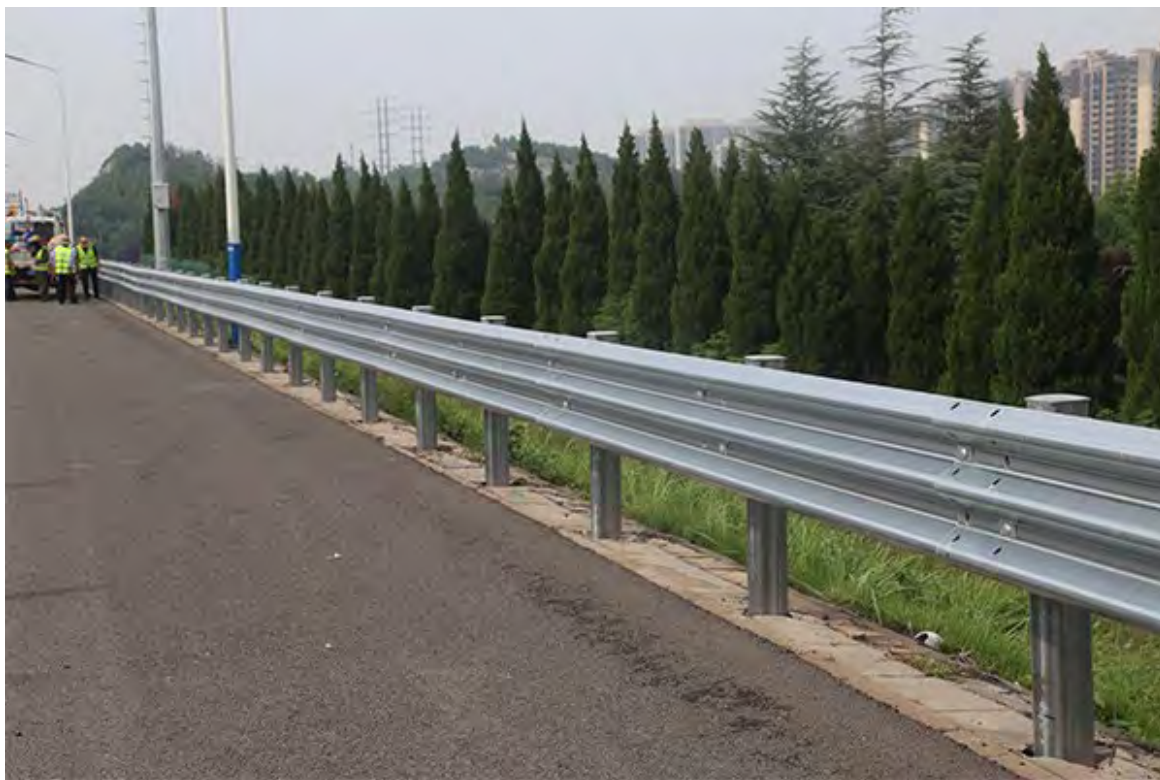
Фиг. № 4 „Метална еластична ограда (тип W-профил)“
