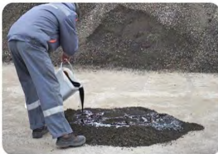
Добавяне на високоякостен модификатор
