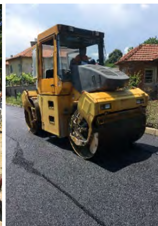
Полагане на смес от RAP, Фрезобит и уплътняване
