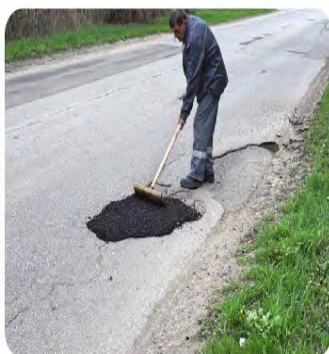
Разстилане на модифицирания RAP и подравняване на сместа
