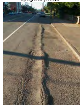
Фиг. № 2 „Образуване на коловози по надлъжна следа в градска улица“
